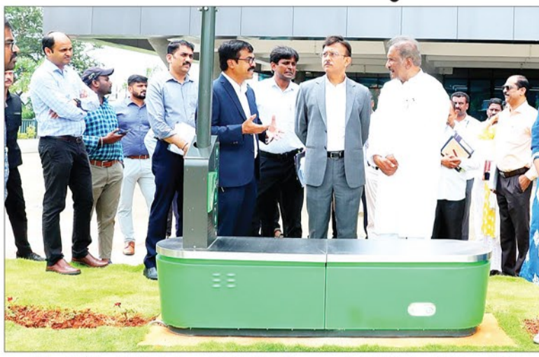
ಇಂಧನ ಸಚಿವ ಕೆ.ಜಿ.ಜಾರ್ಜ್ ಕೆಆರ್‌ಇಡಿಎಲ್ ಕ್ಯಾಂಪಸ್‌ನಲ್ಲಿರುವ ಪಿಕ್ಯೋ ಹೈಡ್ರೋದ ಕಾರ್ಯನಿರ್ವಹಣೆಯನ್ನು ವೀಕ್ಷಿಸಿದರು. ಇಂಧನ ಇಲಾಖೆ ಅಪರ ಮುಖ್ಯ ಕಾರ್ಯದರ್ಶಿ ಗೌರವ್ ಗುಪ್ತಾ, ಕೆಆರ್‌ಇಡಿಎಲ್ ವ್ಯವಸ್ಥಾಪಕ ನಿರ್ದೇಶಕ ಕೆ.ಪಿ.ರುದ್ರಪ್ಪಯ್ಯ ಮತ್ತಿತರರು ಇದ್ದರು.
